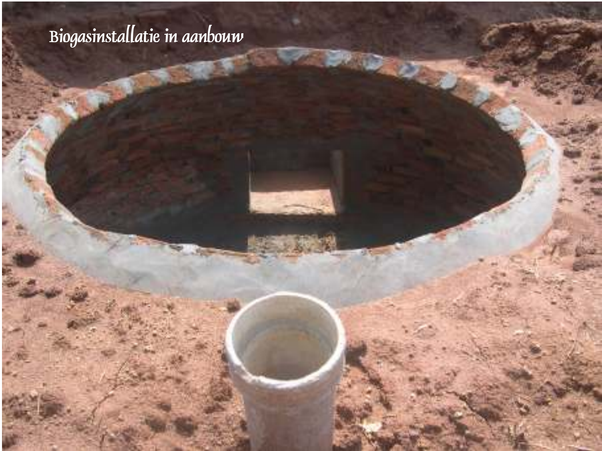
Koerienstal in aanbouw
